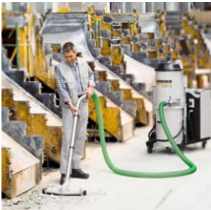
Verwijdering van betonresten in de bouw
